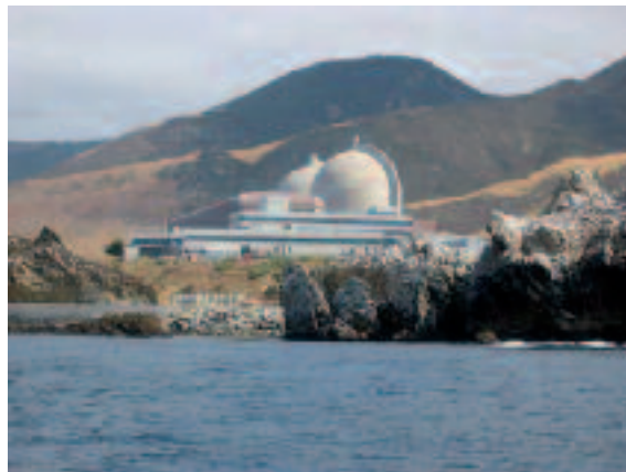
Vista de una central nuclear dotada de dos reactores. Se encuentra situada junto al mar, que cumple la función de sumidero de calor de la energía no aprovechable en el proceso.
